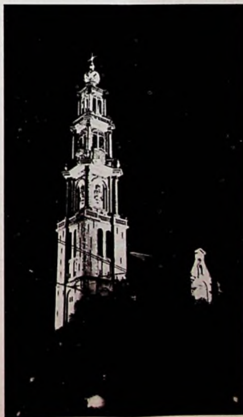
De bestaande permanente verlichting van de Westerstoren werd belangrijk versterkt. Toegepast zijn 6 Infraror schijnwerpers, elk van 3 kw.
