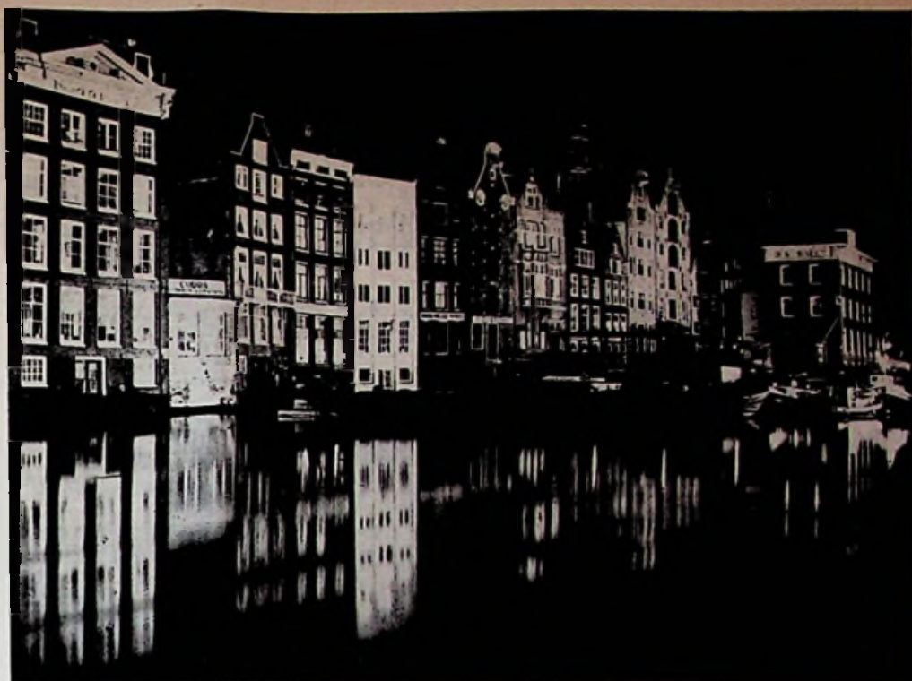
De verlichting van in het water staande gevels aan de linkerzijde van het Damrak (gerekend vanaf het Centraal Station) bleef ongewijzigd; 24 schijnwerpers met een totaalverbruik van 22 kw doen deze gevelrij 's avonds recht wedervaren. (foto's GEB A'dam)
